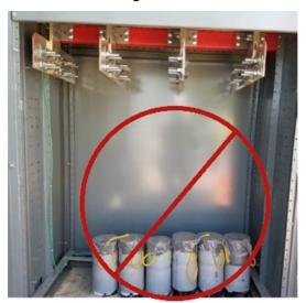
Figure 39—Example of Unacceptable Conduit Installation, Conduits Too High
