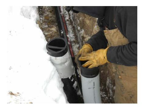
Figure 28—Plugging the Conduit
