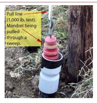
Figure 27—Conduit Proofing
