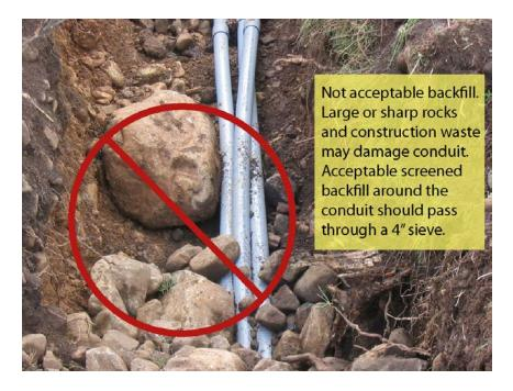
Figure 13—Unacceptable Backfill
