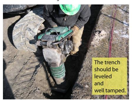
Figure 4—Tamping the Conduit Trench
